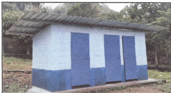
Instalación de techo de lámina troquelada con el debido mantenimiento de las paredes con la pintura de las paredes de los baños sanitarios.
