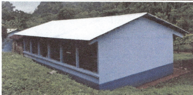
Finalización con la cubierta de lámina troquelada, la aplicación de pintura en muros exteriores e interiores.
