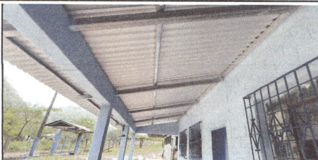
Vista del resultado final de la instalación de la estructura de techo de metal y la cubierta de lámina troquelada.
